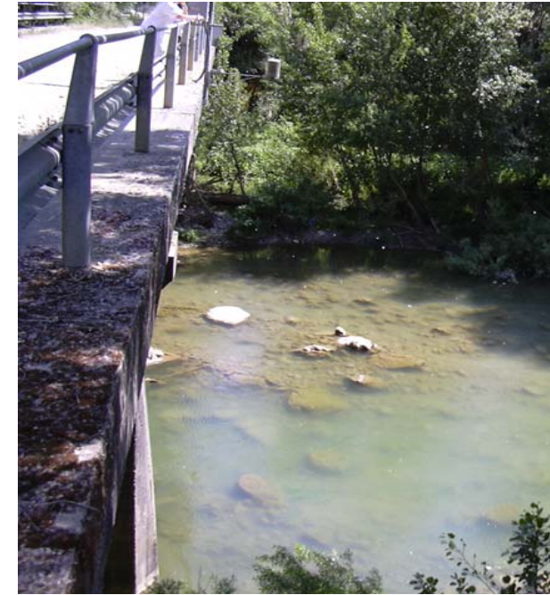
Idrometro a PONTE A MONTEPESCHINI
